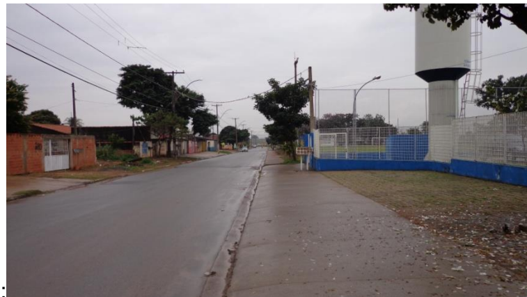
Figura 2: Rua com infra-estrutura adequada, drenagem e pavimentação, obras realizada com recursos oriundos do PAC.
