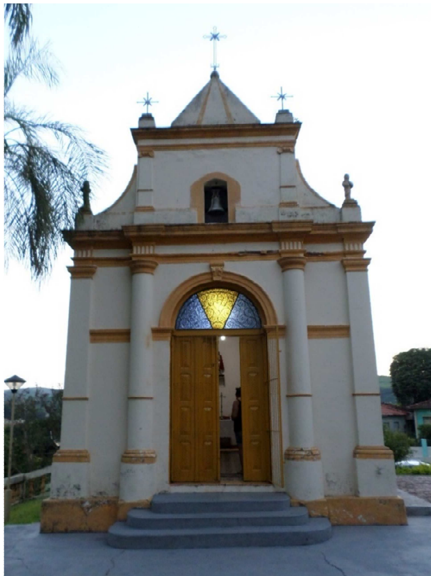
Figura 5: Capela do Bom Jesus, uma das únicas que mantém alguns dos aspectos arquitetônicos originais do século XIX em boas condições na cidade (Foto tirada em 14/12/2017).
