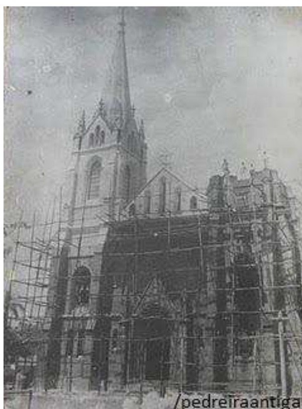
Figura 14: A construção da segunda torre da Igreja Matriz de Sant'Anna e em processo de acabamento. Registro fotográfico da década de 1950 (Disponível em Pedreira Antiga).
