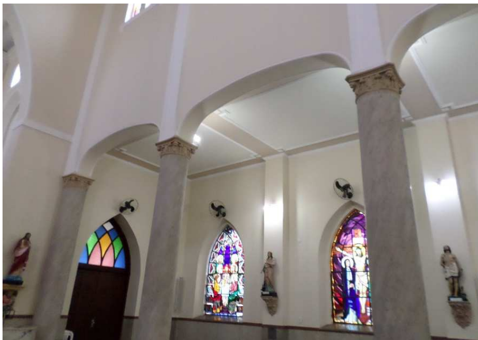
Figura 15: Detalhes dos arcos abatidos (Fotos tiradas em 03/11/2017).
