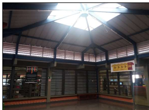
Figura 51 – Aberturas voltadas para o átrio da biblioteca.
