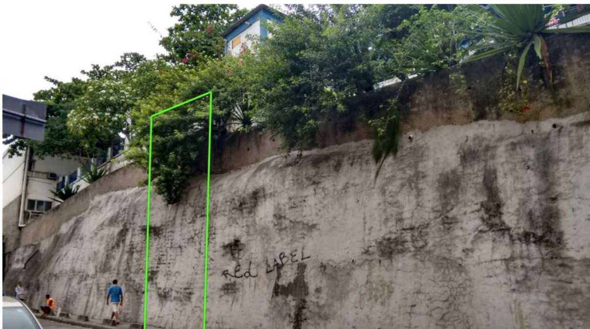
Figura 6: Rocha com demarcação da área onde pode ser instalada a plataforma elevatória
