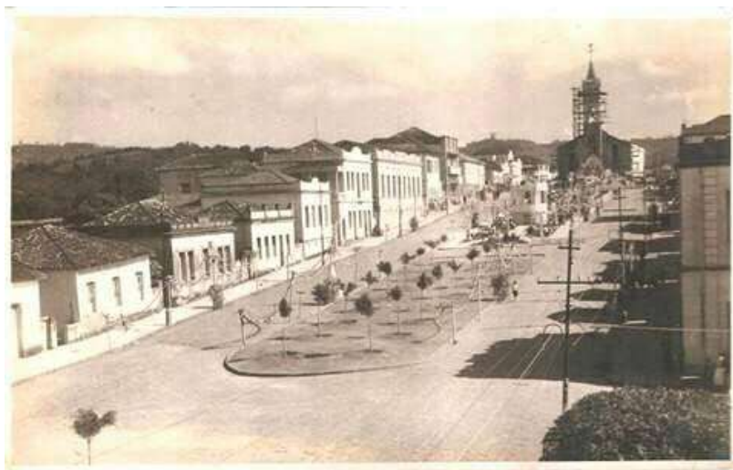
Figura 11: Vista da área central da cidade.
