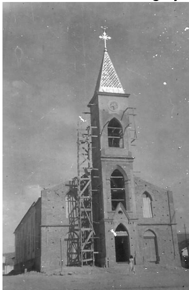
Figura 12: Vista da Fachada da Igreja em reforma.
