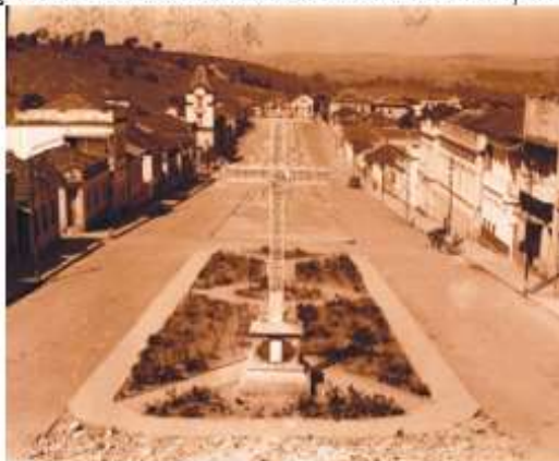
Figura 9: Praça central da cidade de Cabo Verde, início das obras.
