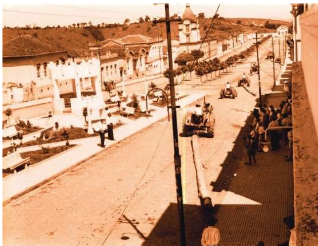
Figura 10: Praça central da cidade de Cabo Verde, fim das obras
