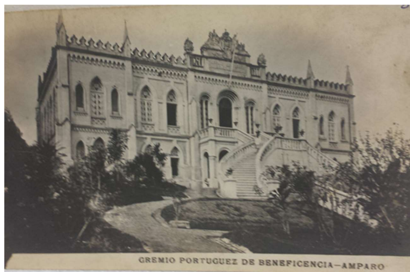
Figura 18. Fachada Principal Do Hospital Beneficência Portuguesa.
