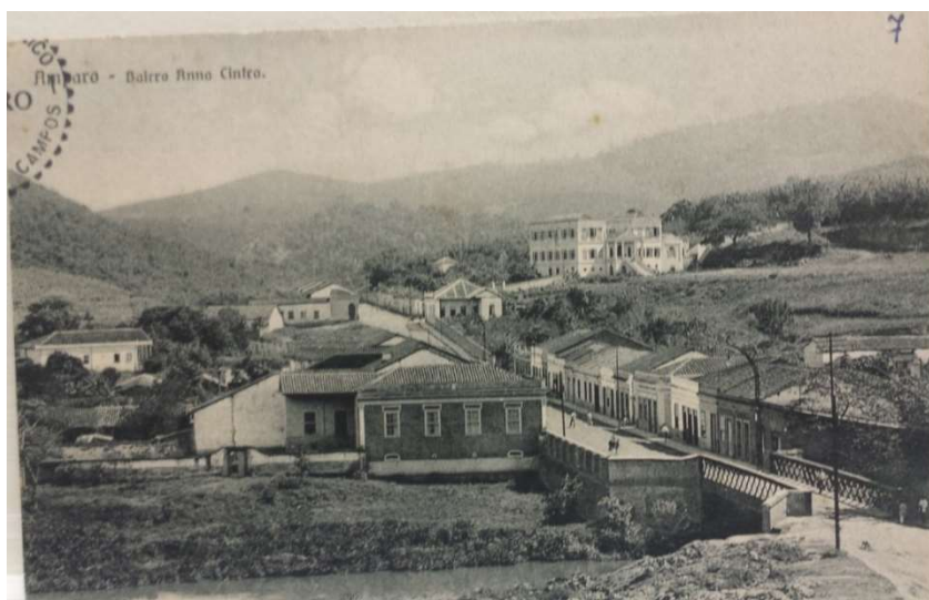
Figura 2. Ponte Sobre O Rio Camanducaia, Ao Fundo Na Parte Superior Apresenta-Se A Santa Casa “Anna Cintra”.
