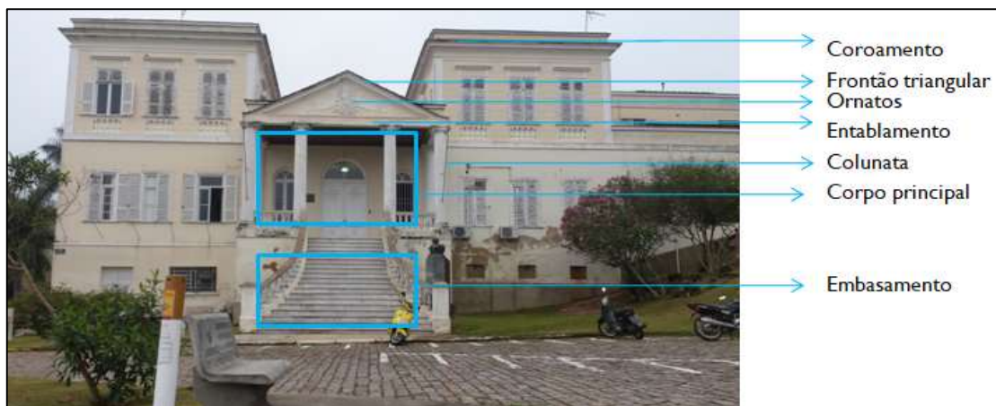
Figura 7. Fachada Santa Casa Anna Cintra, 2019.
