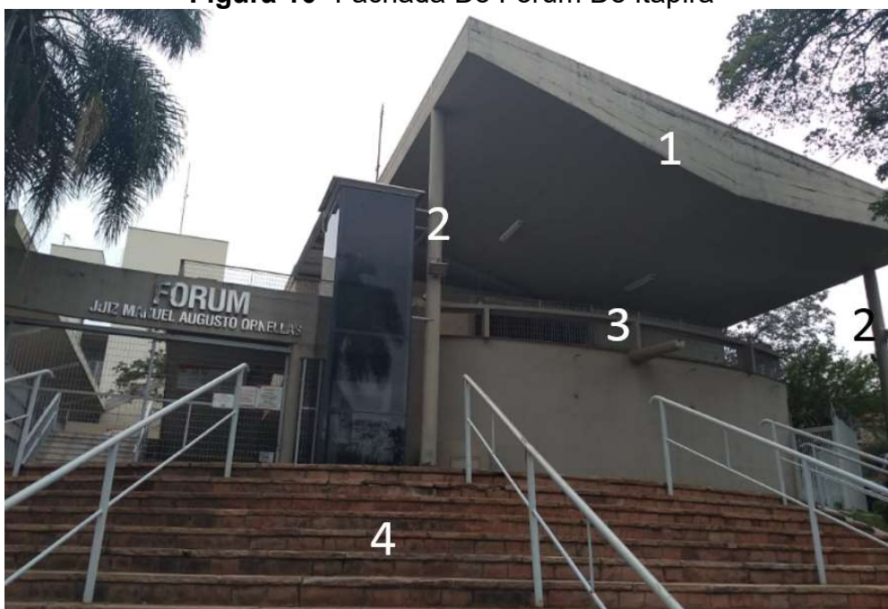
Figura 10- Fachada Do Fórum De Itapira
