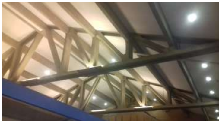
Figura 3. Treliça em concreto armado tipo Howe.
