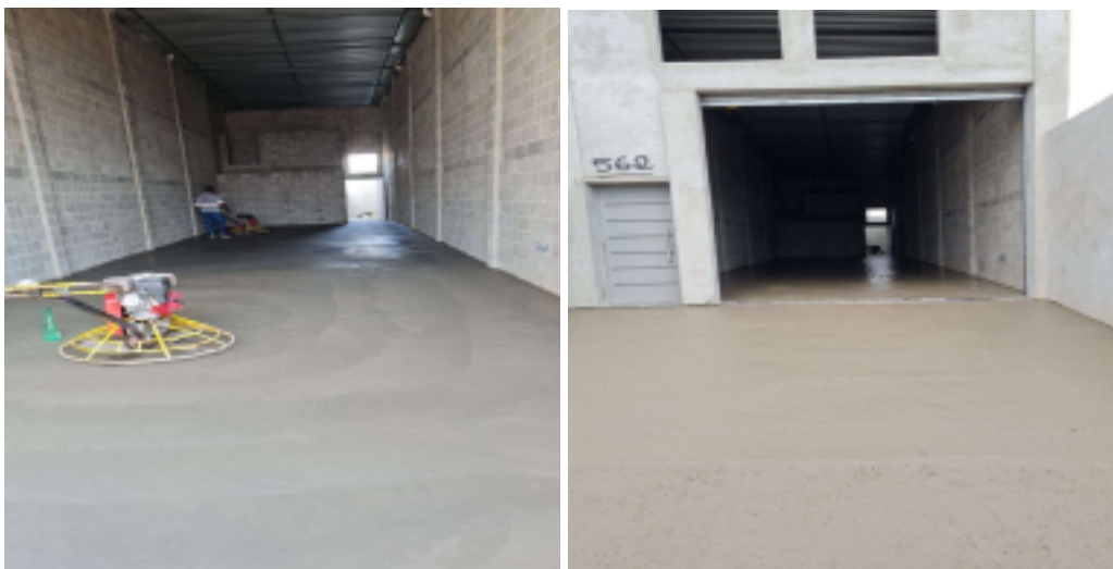
Figuras 17 e 18: Concreto polido e acabado
