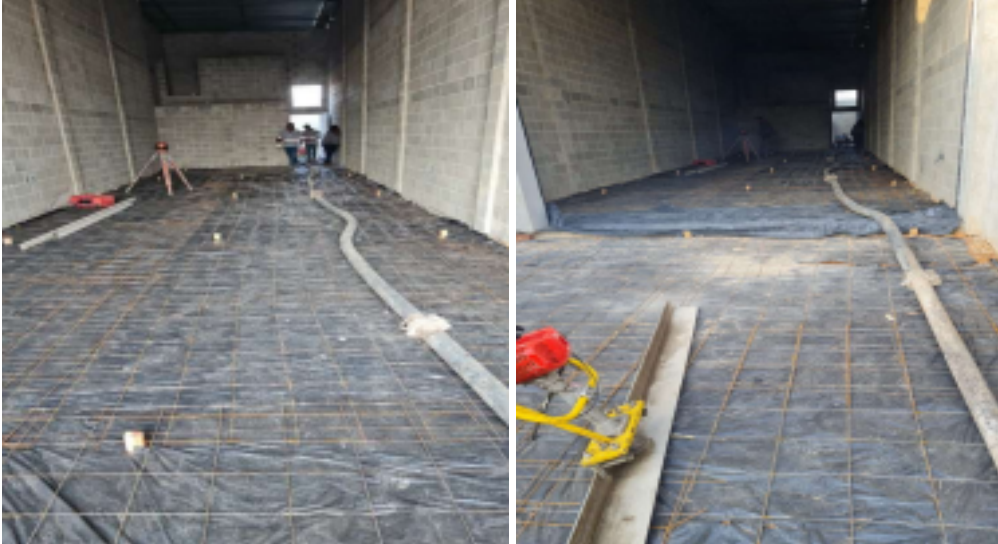
Figuras 15 e 16: Preparação do piso para concretagem
