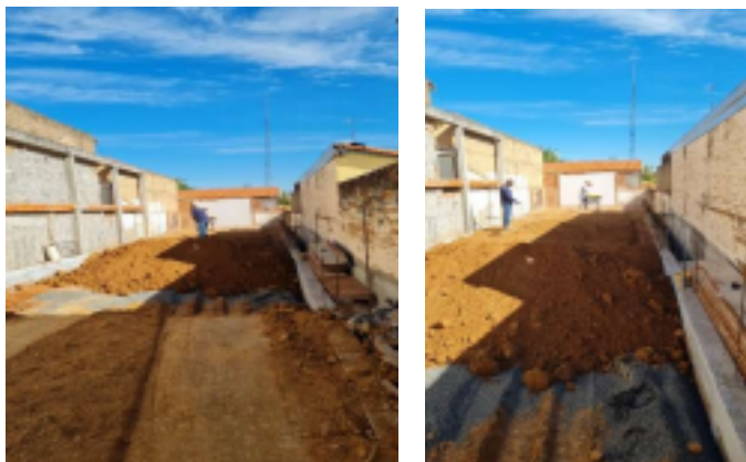
Figura 12: nivelamento do terreno Figura 13: Compactação do terreno Fonte: Elaborado pelos autores
