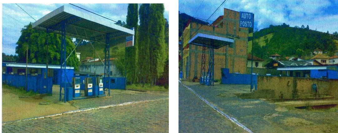
Figura 2 - Posto de combustível em funcionamento (antes de 2006).
