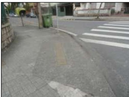
**Figura 11**: Inadequação do posicionamento da sinalização tátil de alerta
