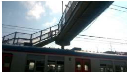
Foto 12: Passarela – Estação Brás Cubas. Fonte: da autora.
