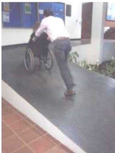
Fig. 157 – Rampa de acesso bloco D34
