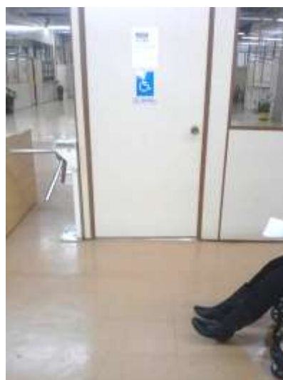
Figura 5 – Porta de acesso à BCE
