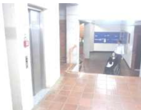
Figura 179 – Elevador para acessibilidade do Bloco D34
