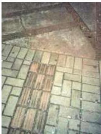
Figura 24 – Final da sinalização Tátil.
