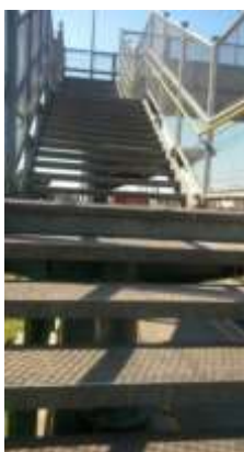
Foto 14: Escadas – Estação Jundiapéba.
