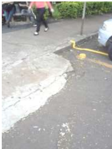
Figura 4 – Rampa de acesso ao passeio
