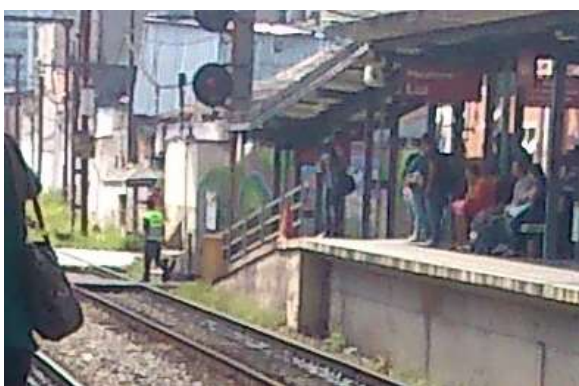
Foto 08: Rampa - Estação Mogi das Cruzes. Fonte: da autora.
