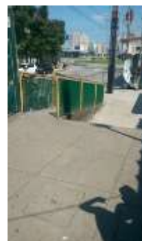
Foto 03: Rampa de acesso Pela R. Álvaro Pavan. Fonte: da autora, 2014.
