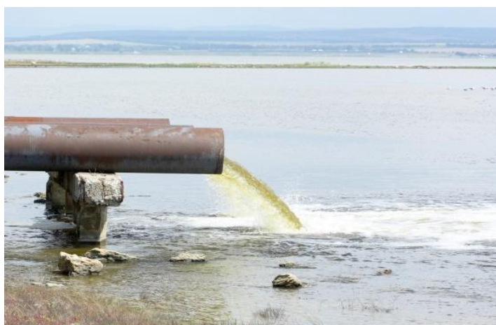
Figura 06: Sistema de esgoto inadequado, contribuindo para a disseminação.
