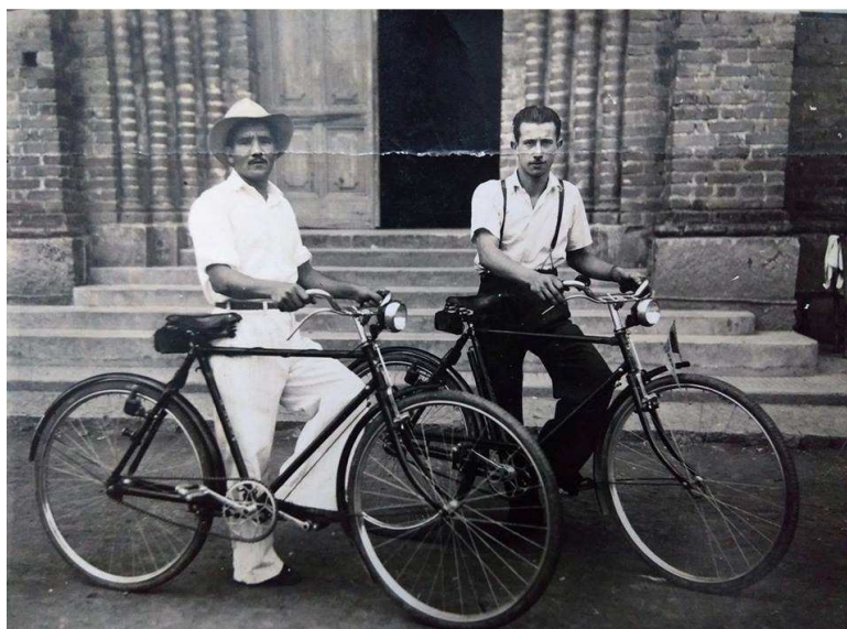
Figura 08: Na foto vemos a porta principal da igreja ao fundo, ainda sem o acabamento nas paredes (Imagem cedida por Mateus Moro).
