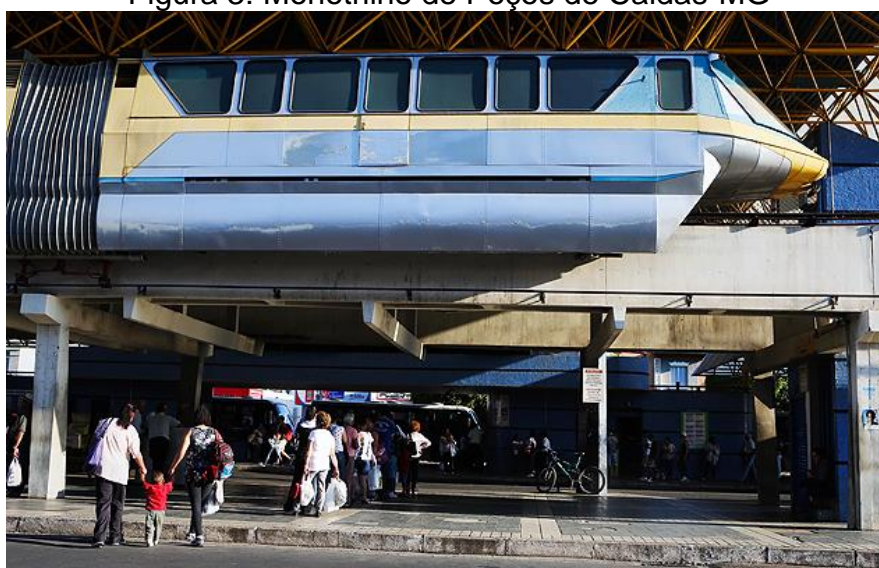
Figura 3: Monotrilho de Poços de Caldas-MG. Via Trolebus. 2016.
