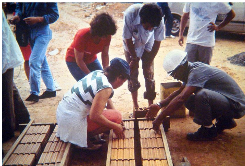
Figura 4 - Estudantes no canteiro de obras produzindo módulo de painel. Fonte: POMPEIA, 2006.
