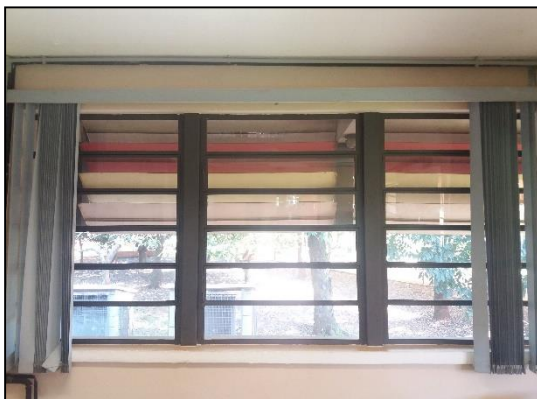
Figura 50 – Janelas da biblioteca voltadas para o exterior do edifício.
