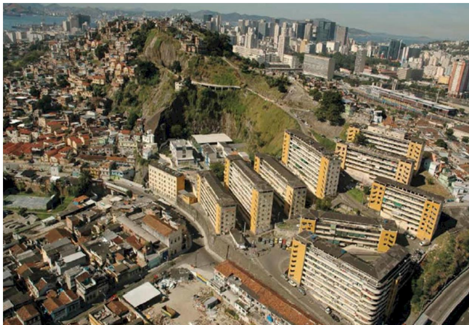
Figura 6 – Conjunto Habitacional Realengo (1942) – Carlos Ferreira. Rio de Janeiro – Brasil
