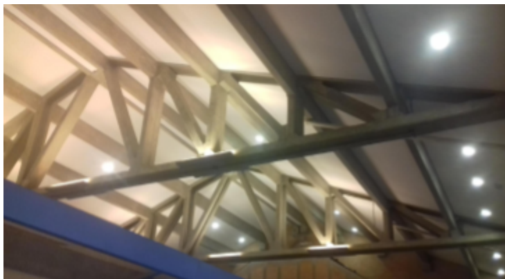
Figura 3. Treliça em concreto armado tipo Howe.
