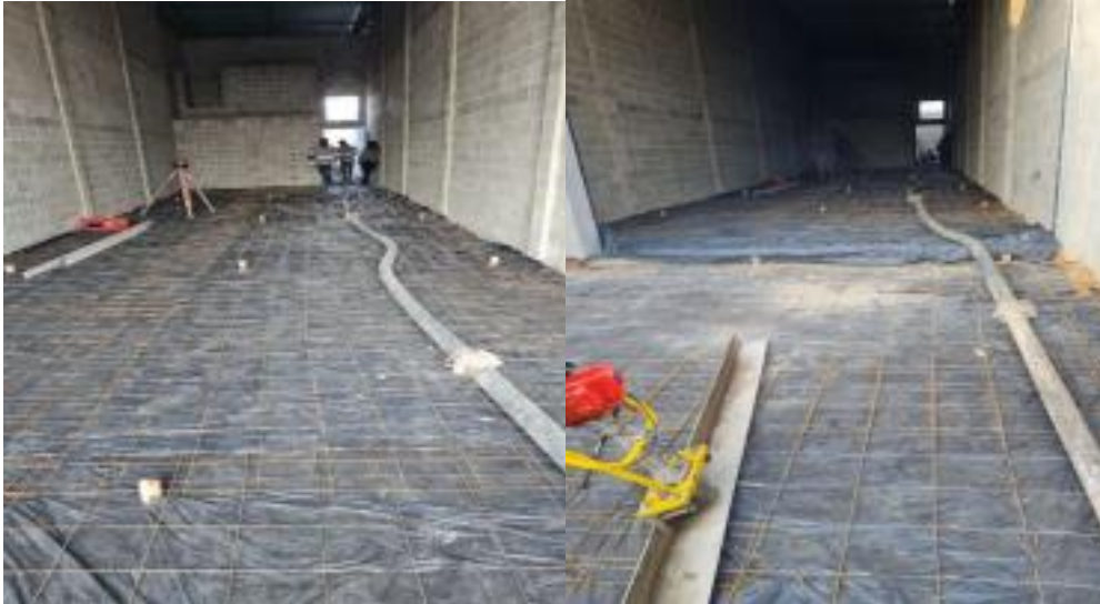
Figuras 15 e 16: Preparação do piso para concretagem Fonte: Elaborado pelos autores
