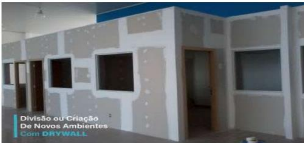
Figura 19: divisórias internas em gesso drywall Fonte: Site Gesso sagitário, 2021
