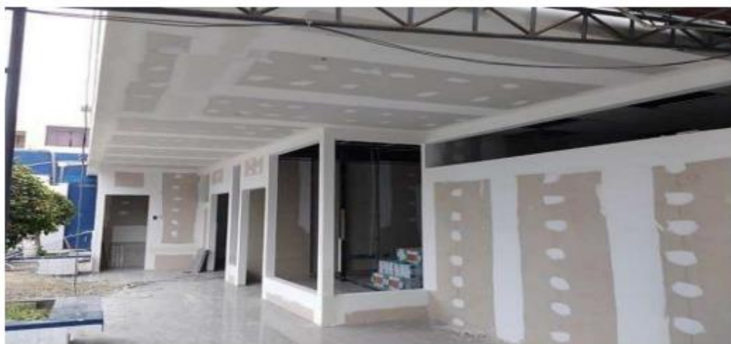
Figura 20: divisórias externas em gesso drywall Fonte: Site Decorando casas, 2021
