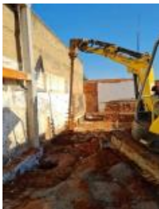
Figura 14: Perfuração das brocas Fonte: Elaborado pelos autores
