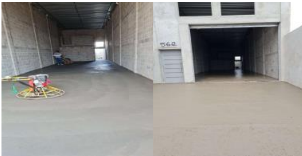
Figuras 17 e 18: Concreto polido e acabado Fonte: Elaborado pelos autores
